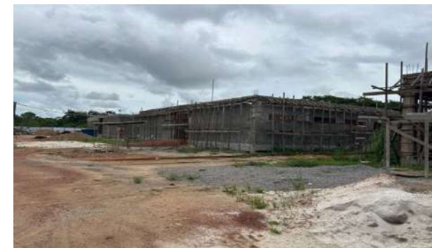
Obra do DFCH
