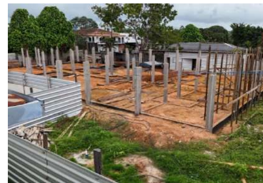
Obra do Bloco Multidisciplinar
