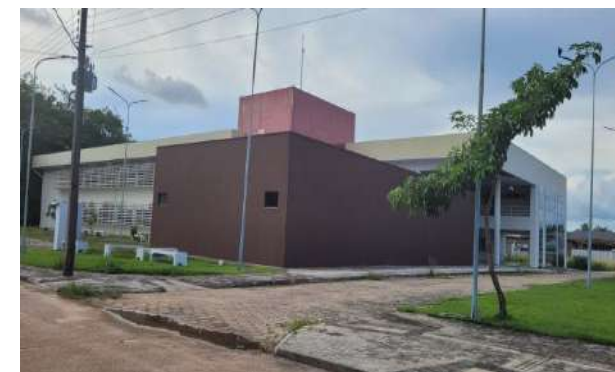
Obra do - DED
