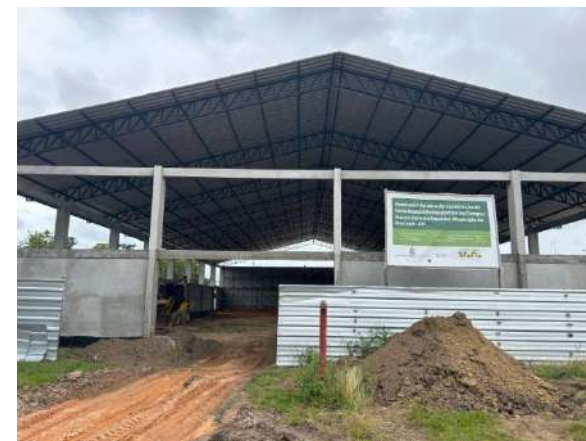
Obra da Quadra Poliesportiva
